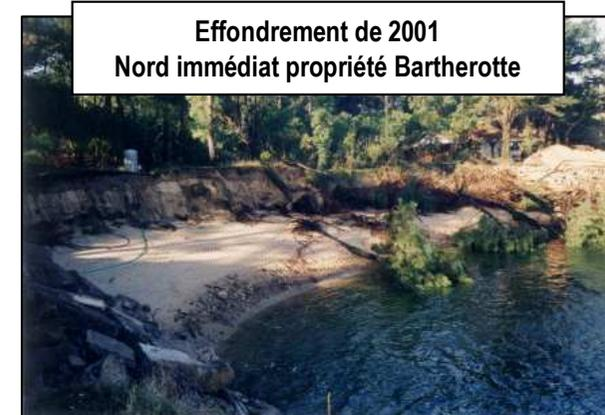
Les abaissements du chenal ont aussi entraînés des effondrements brutaux et soudains comme présentés ci-dessous en 1999 et 2001. Ces effondrements n'ont heureusement entraîné que des dégâts matériels. Des effondrements brutaux interviennent fréquemment sur la plage située en extrémité de la digue Bartherotte, ce qui justifie d'un arrêté d'interdiction d'accès.
